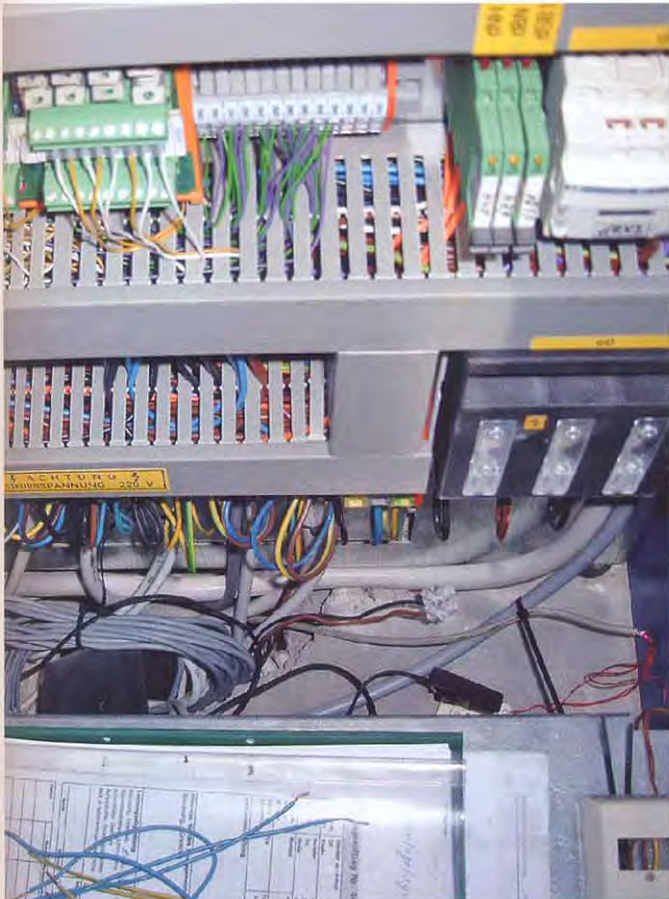
Mangelhafte Schaltschrankinstallation
